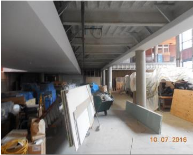
Commons Area in Progress
